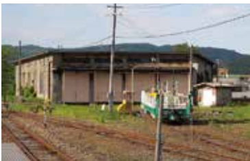
「旧盛岡機関区荒屋新町支区扇形機関庫・転車台」と案内板
